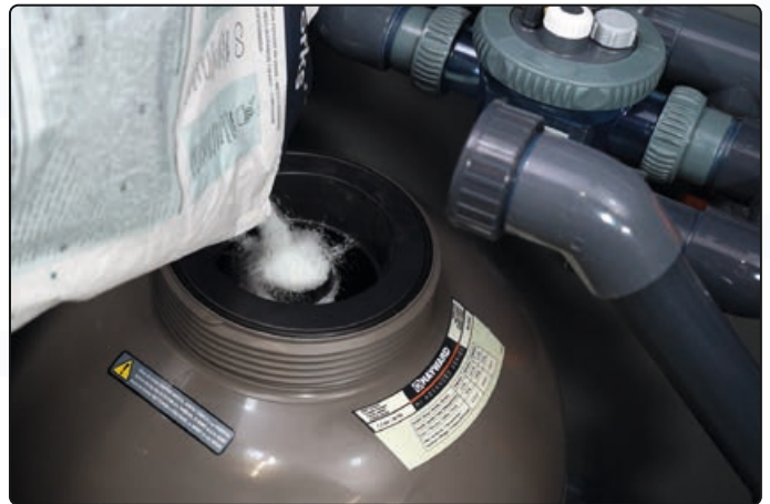
Filtermaterial einfüllen
