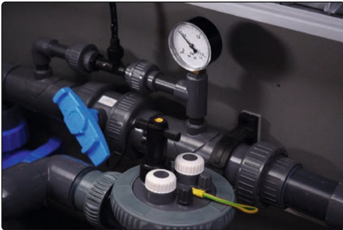
Druckveränderung AOP durch blauen Hahn
