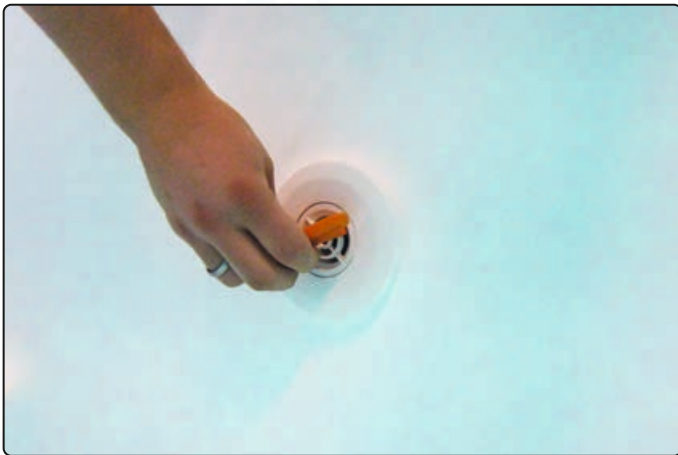
Kugel / Gewinding oder Schutzgitter entfernen
