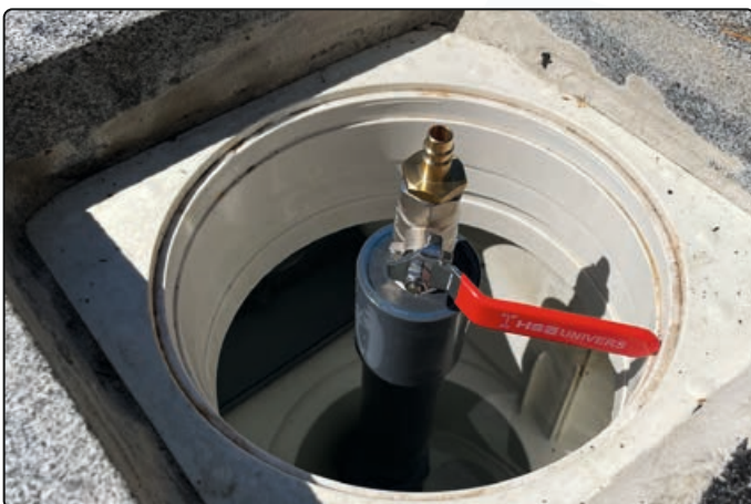
Ausblasvorrichtung in Skimmer stecken
