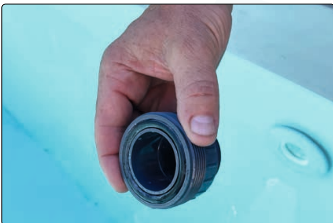
Verschraubung in die oberste Einlaufdüse schrauben
