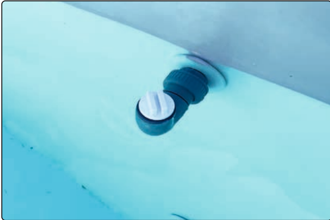
Winterverschlusskappe auf den Winkel schrauben
