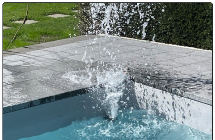
Ausblasen bis kaum noch Wasser kommt
