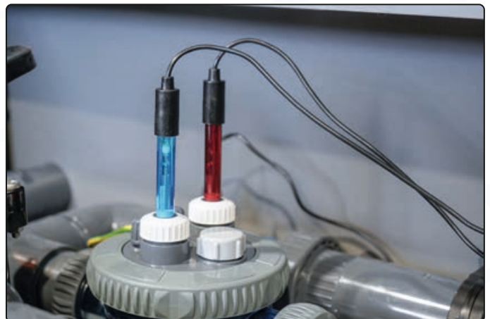
Redox & pH Sonde eingesteckt
