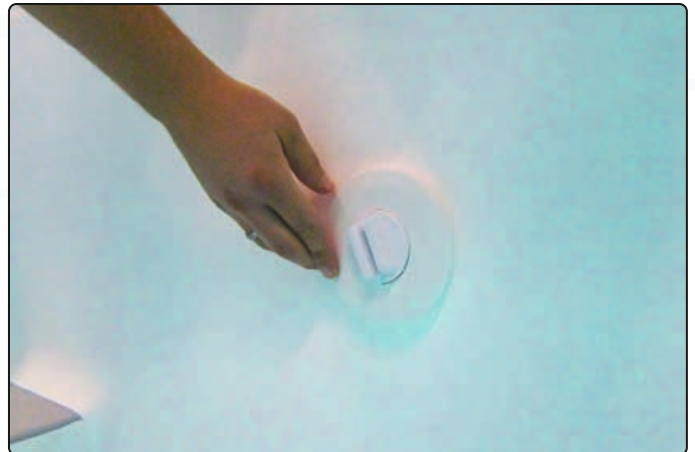
restliche Düsen mit Winterverschlusskappe verschließen
