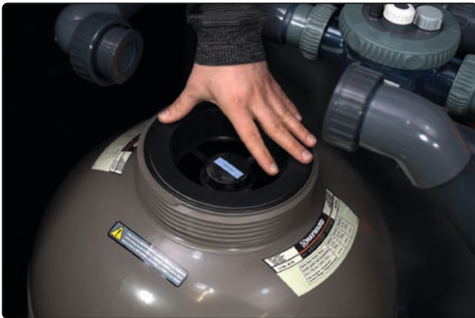
Einfüllhilfe auf Filterkessel legen
