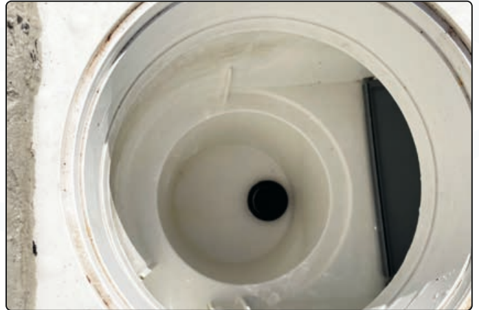
Skimmer mit Winterverschlussstopfen verschließen
