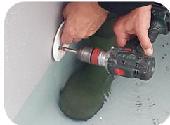
Flanschplatte anschrauben
