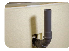
HT-Rohr aufstecken
