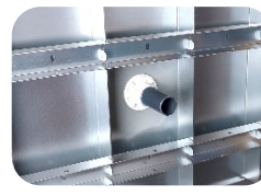
PVC Stützen einkleben
