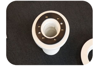
Dichtung ankleben
