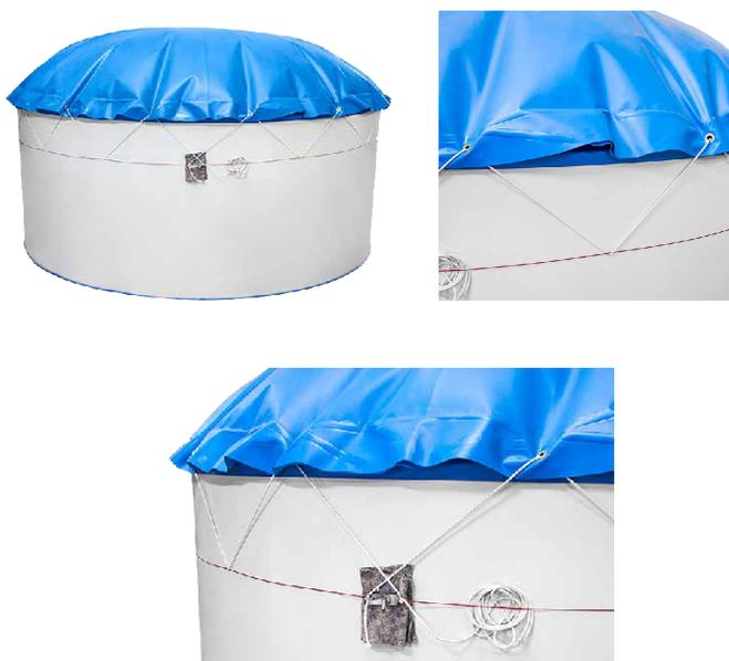
Hierbei wird ein kunststoffummanteltes Stahlseil (wie es beispielsweise auch bei PE-Abdeckungen zum Einsatz kommt) um den Stahlmantel gezogen und mittels einer Ratsche festgezurt. Dieses Seil dient dann als Haltepunkt für das nach unten zu führende und einzuhängende Gummiseil. Achten Sie darauf, zwischen Ratsche und Stahlwand einen geeigneten Unterlegschutz (zusammengefaltetes Vlies oder Pappe) zu verwenden, um ein Zerkratzen der Stahlwandbeschichtung durch die Ratsche zu verhindern.
