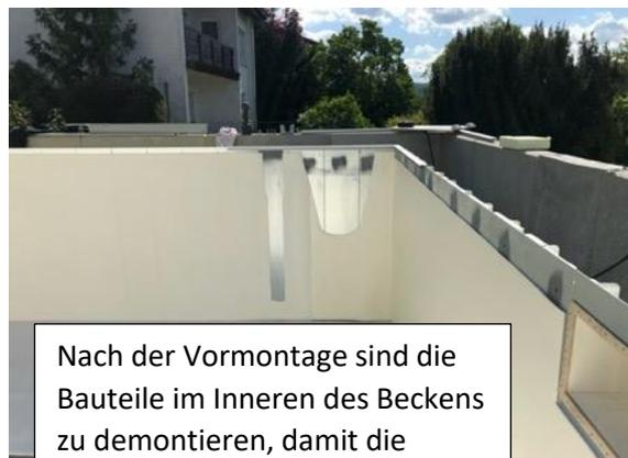
Nach der Vormontage sind die Bauteile im Inneren des Beckens zu demontieren, damit die Softtouch Matte angeklebt und ausgeschnitten werden kann
