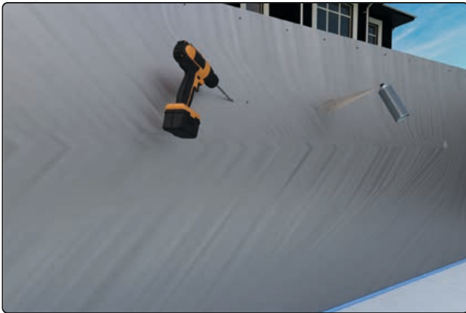
Bohren und verzinken
