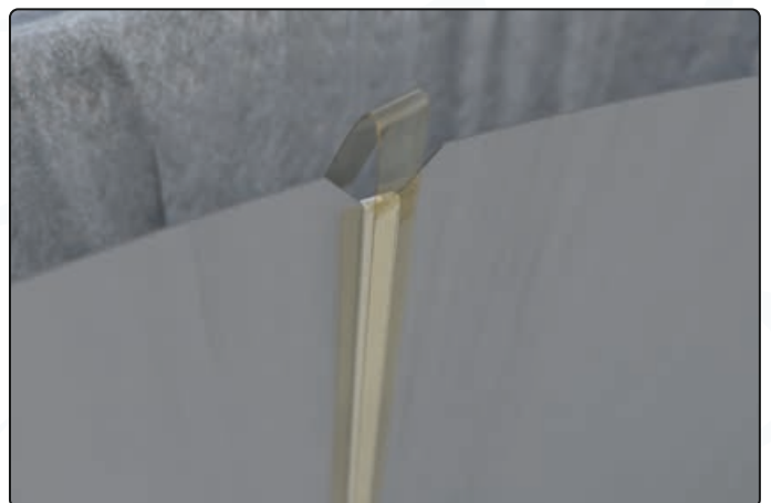
Scharfe Kanten mit Klebeband abkleben
