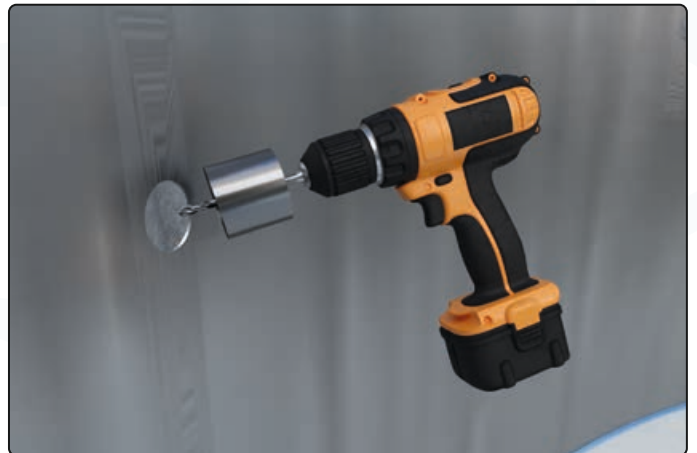
Loch anzeichnen und bohren
