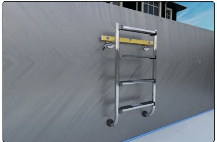
Im Becken positionieren und kennzeichnen
