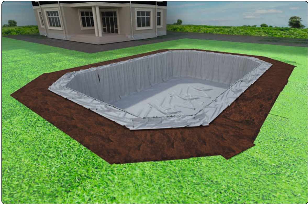
Geotextvlies vollflächig ausgelegt
