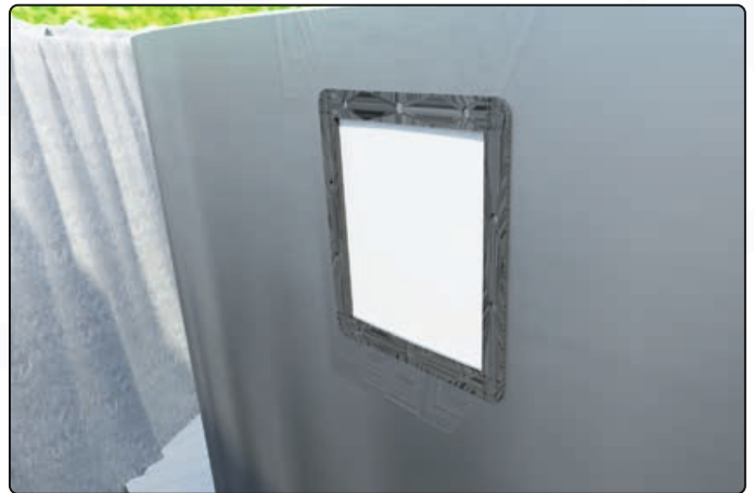
Doppeldichtung auf die Rückseite der Skimmeröffnung stecken
