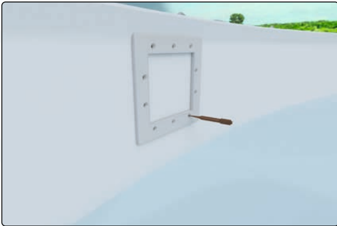
Lochbild nach dem Innenflansch anzeichnen und vorstechen
