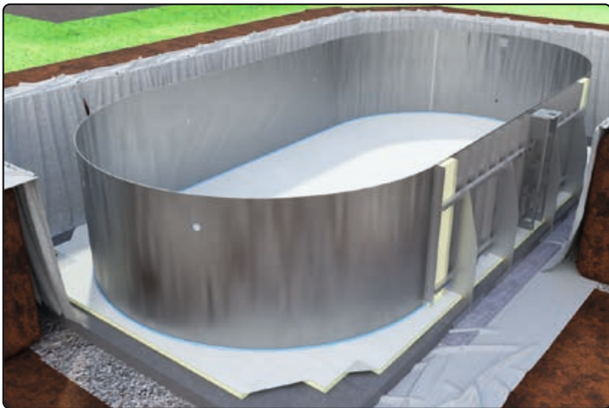
Stahlwand aufstellen
