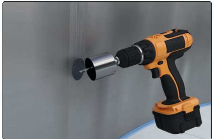
Loch anzeichnen und bohren
