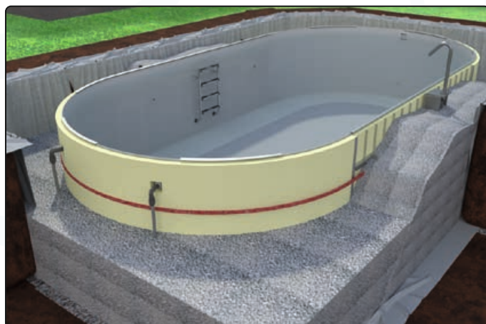
Kies gleichmäßig in der Baugrube einbringen
