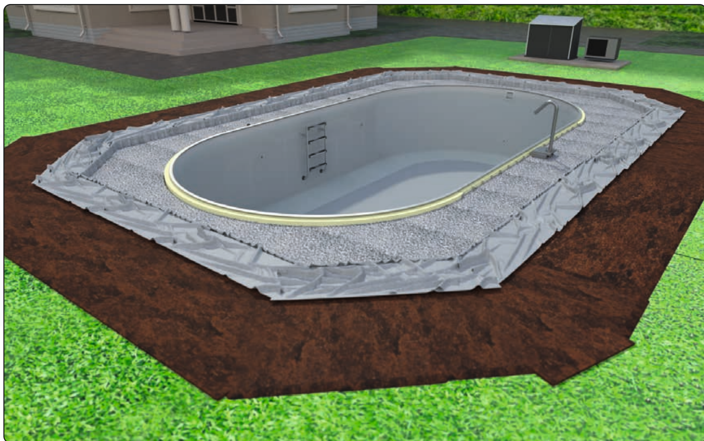
Baugrube gleichmäßig mit Kies aufgefüllt
