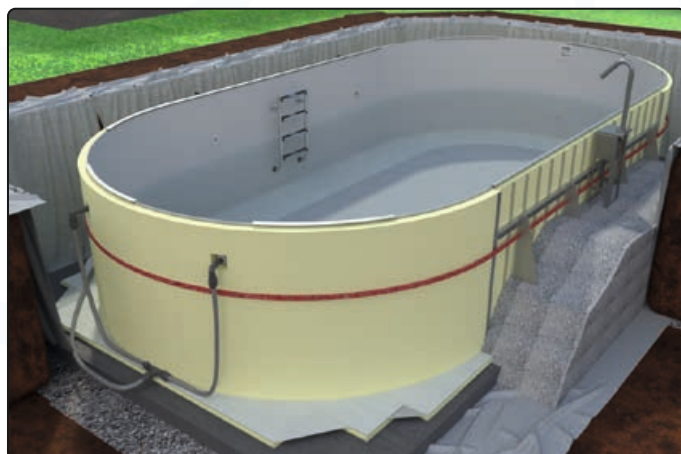
Kies auf gleiche Höhe wie Wasserstand füllen
