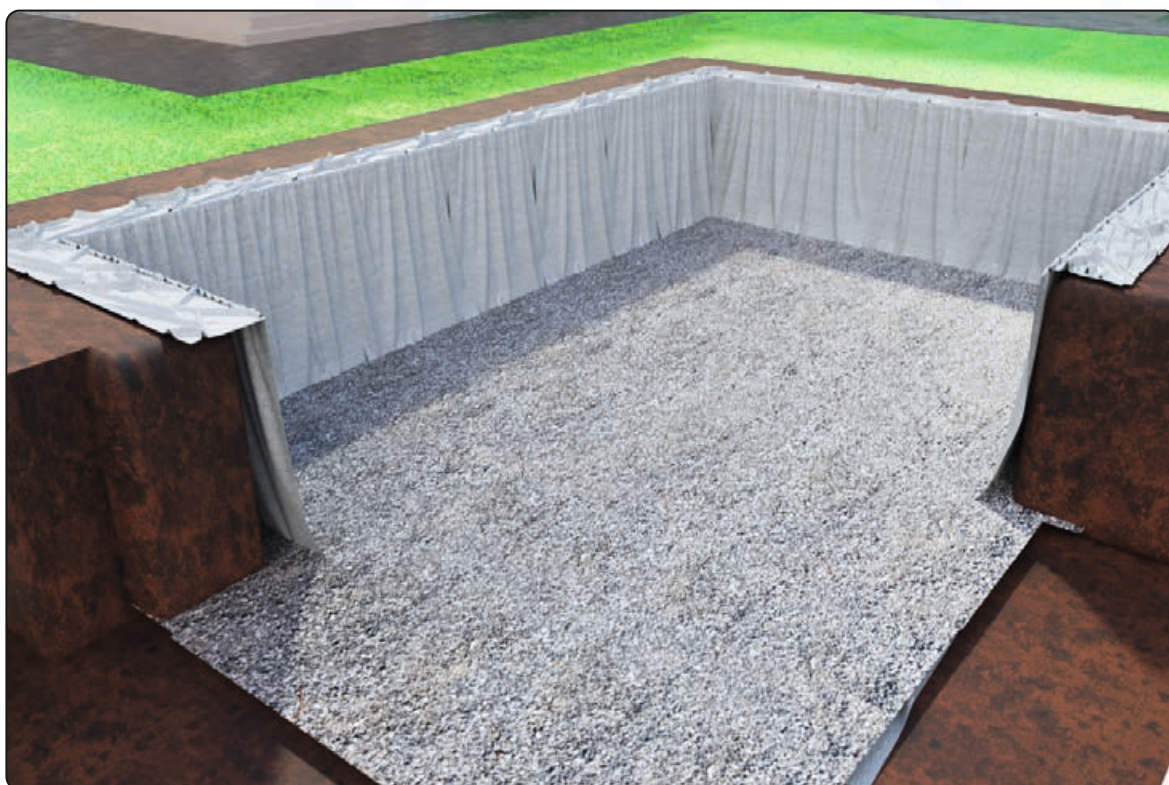
Falls erforderlich: Baugrube mit zusätzlicher Schotterschicht und Geotextvlies ausgekleidet
