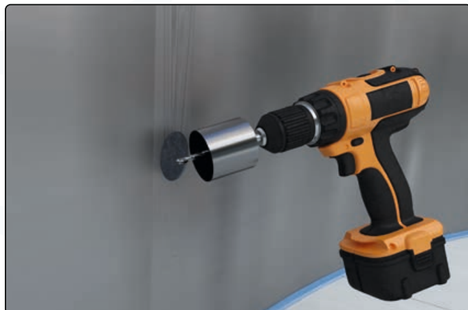
Loch anzeichnen und bohren
