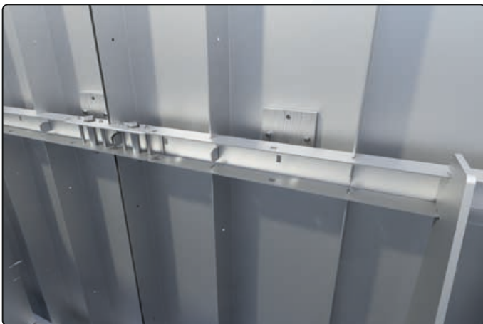
Flansche mit Schrauben durch die Löcher stecken
