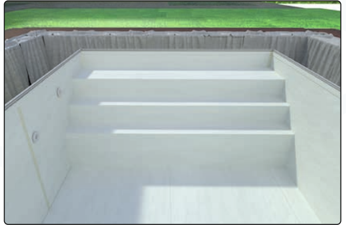
Die Treppe wird vollflächig mit Softtouch beklebt
