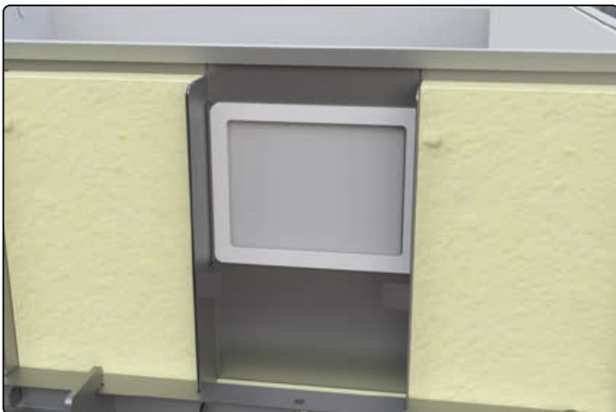
Doppeldichtung auf die Rückseite der Skimmeröffnung stecken
