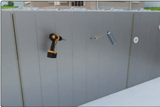
Bohren und verzinken
