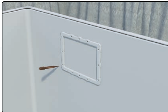
Lochbild nach dem Innenflansch anzeichnen und vorstechen
