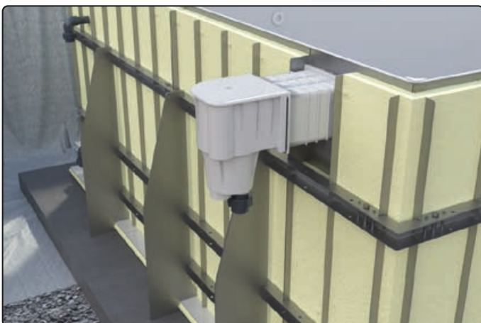
Skimmer mit der Verlängerung ansetzen
