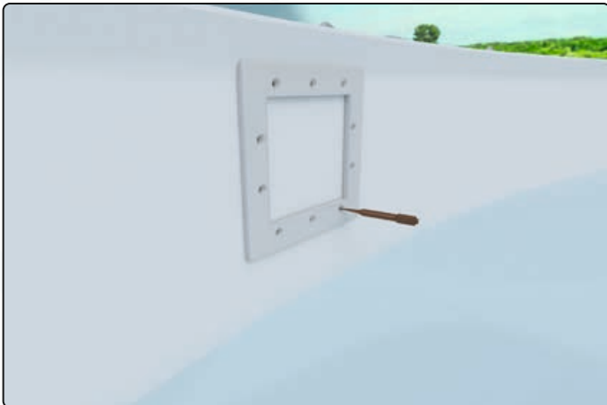
Lochbild nach dem Innenflansch anzeichnen und vorstechen
