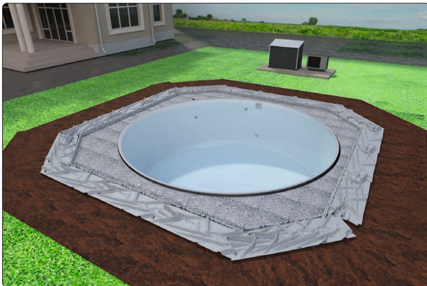
Baugrube gleichmäßig mit Kies aufgefüllt
