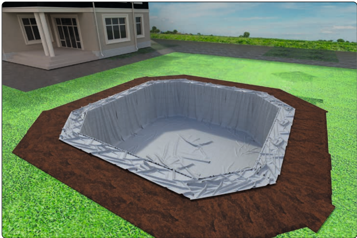
Geotextvlies vollflächig ausgelegt
