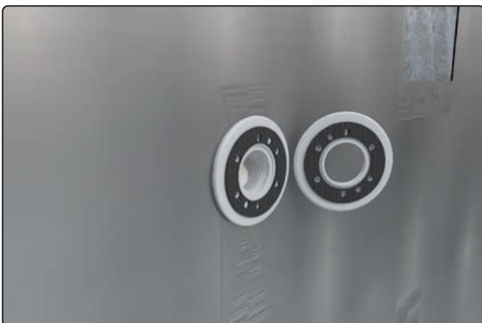
Kleben Sie die Dichtungsscheiben auf
