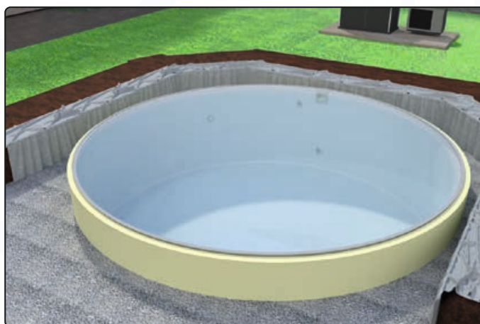
Kies gleichmäßig in der Baugrube einbringen
