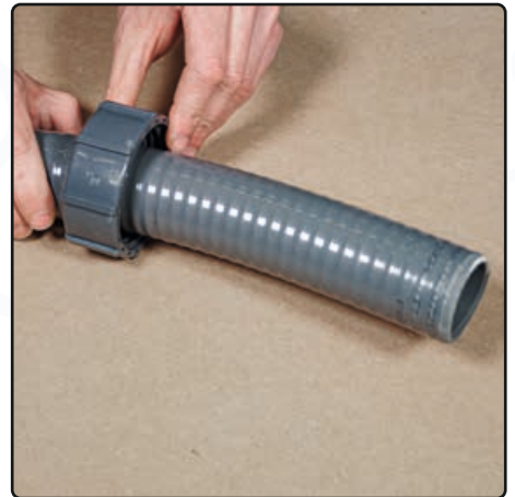
Überwurfmutter aufziehen
