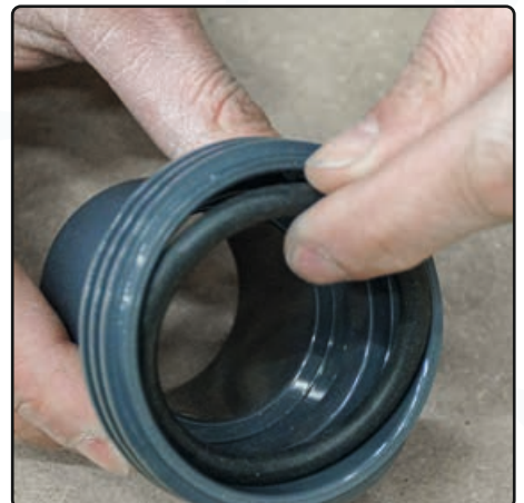
Dichtung einlegen
