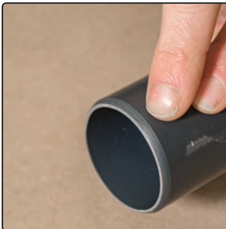
Phase angeschliffen
