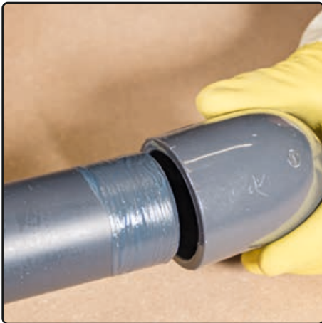
Bauteile verbinden (viertel Drehbewegung)
