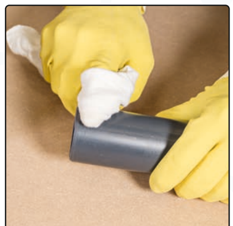
Außenverbindung reinigen
