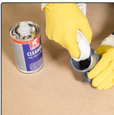
Innenverbindung reinigen
