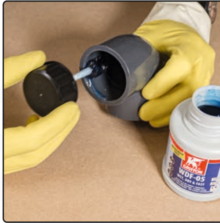
Kleber innen auftragen
